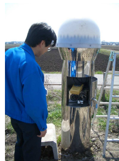
写真 4-3-6. 高岡端点（受信機収納部）
