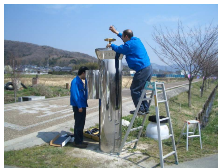
写真 4-3-8. 国松端点・アンテナ設置
