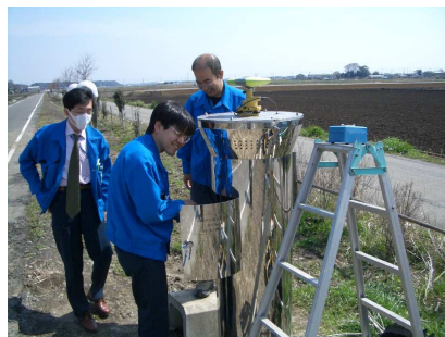
写真 4-3-5. 高岡端点（アンテナ収納部）
