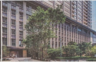
グリーンパレー側(西面)外観
