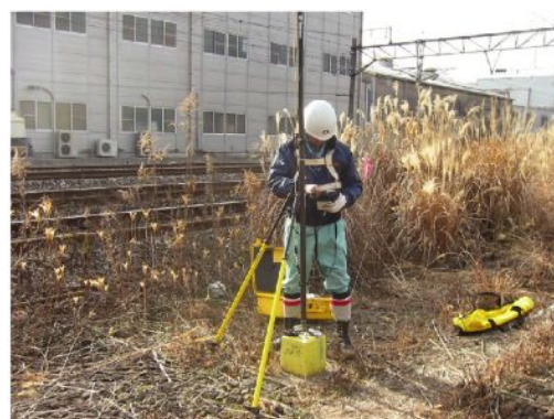
▲鉄道用地内にある基準点の経年経過の管理
