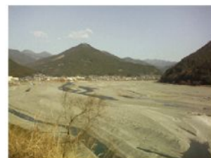
▲一級河川大井川 （上長尾地区50.8km付近より）
