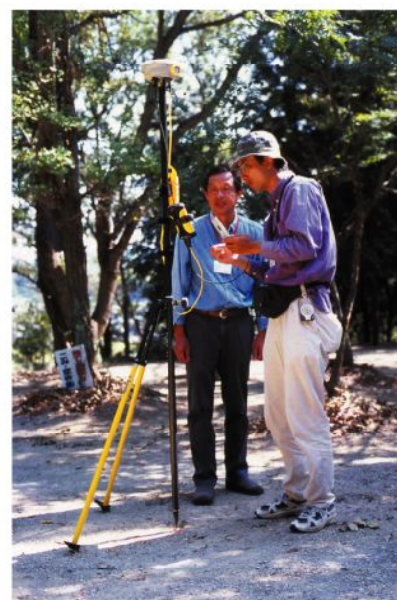
▲VRS-RTK観測（前方部）
