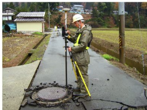
▲VRS-RTK観測(標高を決定)
