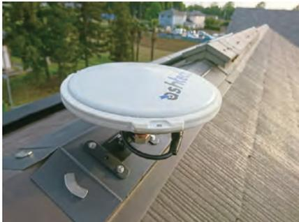
図1 自宅屋根に設置したGNSS基準局
