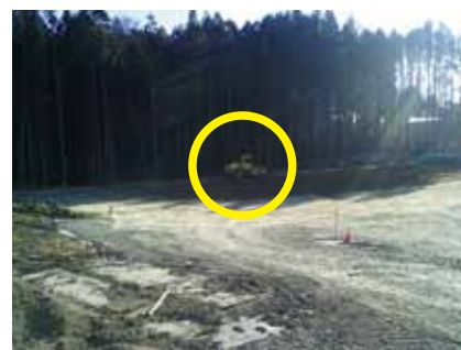
▲現場稼働状況:杉林(北西)の際を転圧作業中 取得衛星:8 個～9 個 FIX
