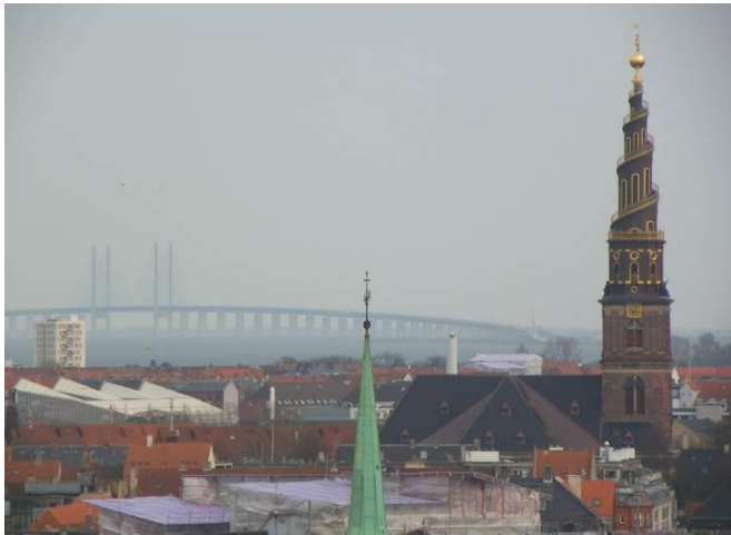
写真7. 救世主教会の尖塔とオーレスン海峡大橋。
