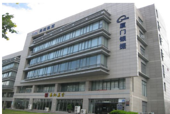
写真6 SD社のビル(2階～4階の3フロア)
