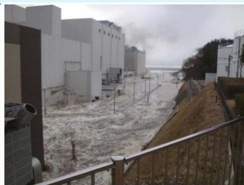
津波により大量の海水が流れ込んだ福島第二原発1号機付近(3月11日撮影、東京電力提供)
