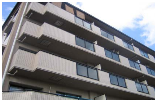
写真3 H1 から北東の5階建てマンション
