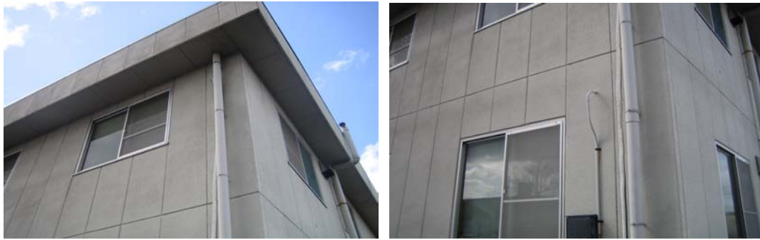
写真1 A1 から北西の建物(左:2階を見上げた様子、右:1階)
