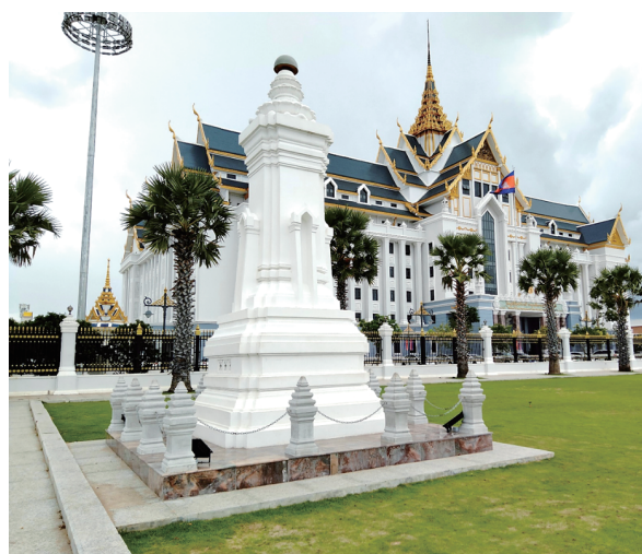
図3. プノンペンにある国土管理・都市計画・建設省庁舎の前に設置された電子基準点
