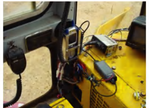
▲移動局システム設置状況
