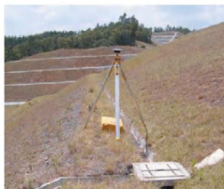
▲造成工事現場の作業風景
