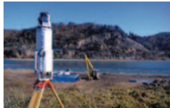
地上型レーザスキャナの計測風景 地上型レーザスキャナは様々な対象物の測定が可能です。
