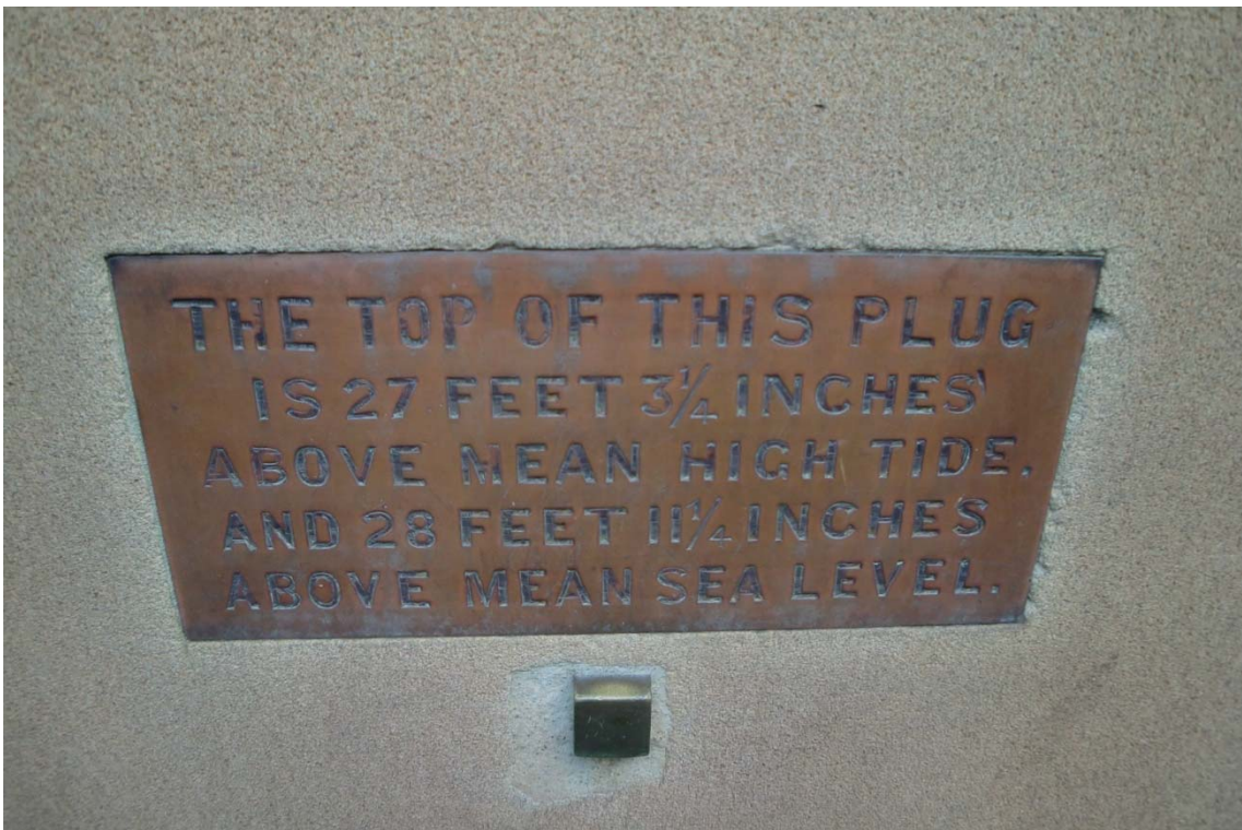
ビルの壁面にある水準標
