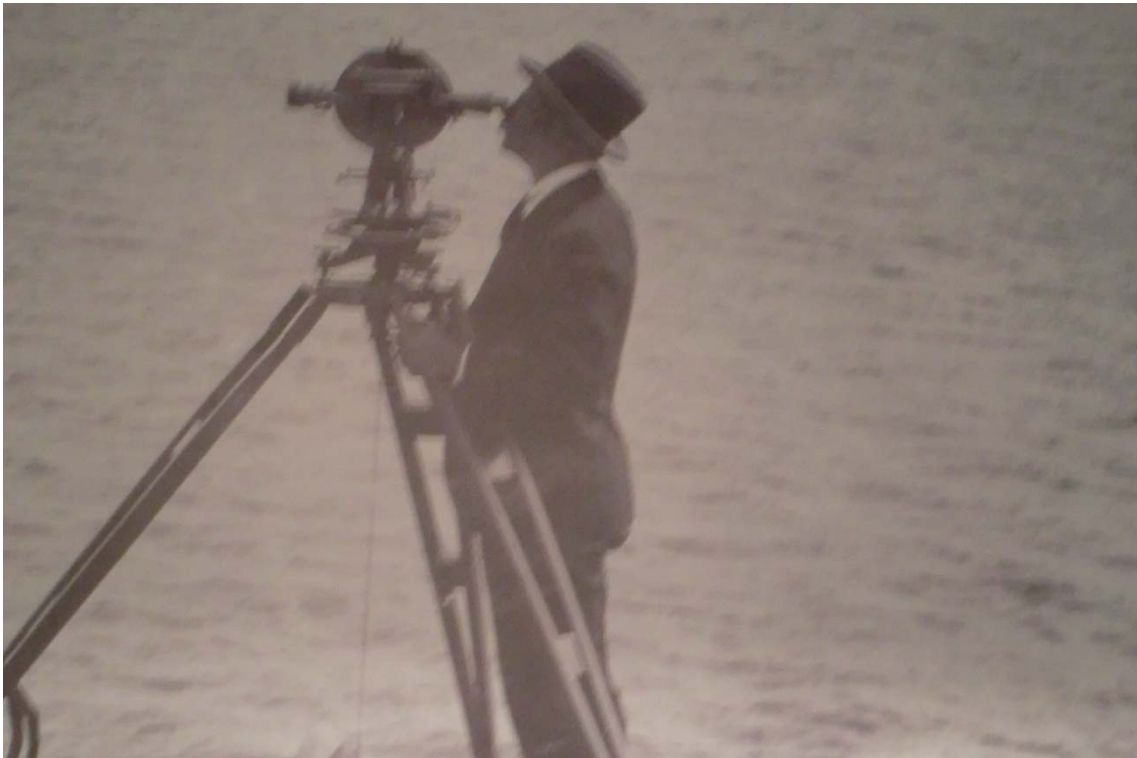
シドニーブリッジ建設時の測量の様子
