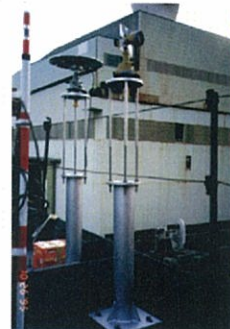
ケーソンへのGPSアンテナ設置状況
