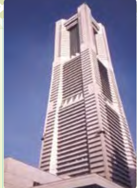
요코하마 랜드마크타워 지상 70층, 높이 296m의 초고층 빌딩은 요코하마의 상징적 존재. 69층의 전망 플로어 「스카이가든」에서의 조망은 최고.
